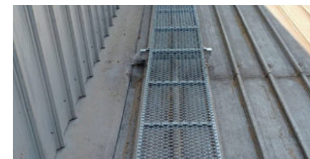
ทางเดินบนหลังคา (Walk Way)
