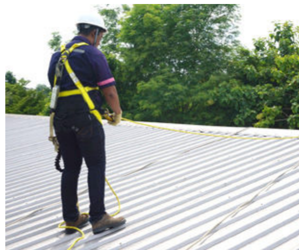
การสวมชุดเข็มขัดนิรภัยแบบเต็มตัว (Full Body Safety) และสายช่วยชีวิตแบบ 2 ตะขอ
